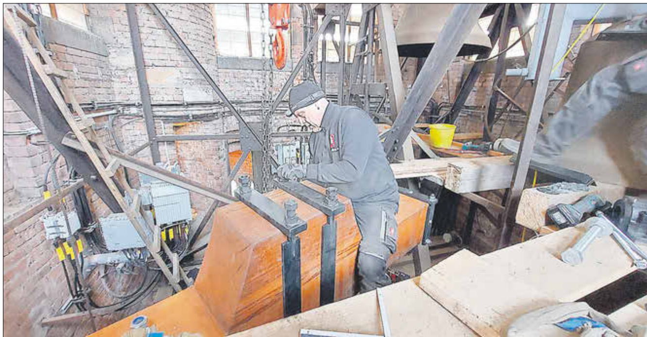
Die Montage des Eichenjochs in der Thomaskirche / Foto: S. Willing
