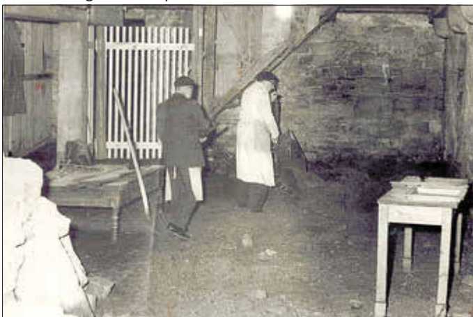
Baumaßnahmen im Kornhaus um 1960 Archivbild Ralf Hill
